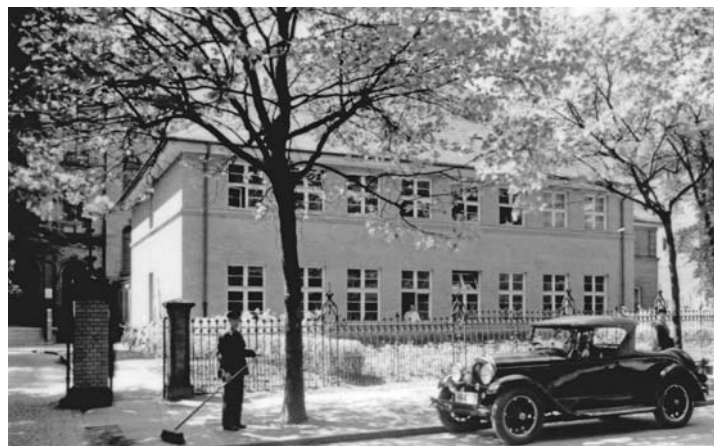
Bild 2: Das Otto-Stern-Gebäude in der Jungiusstrasse 9A um 1930
