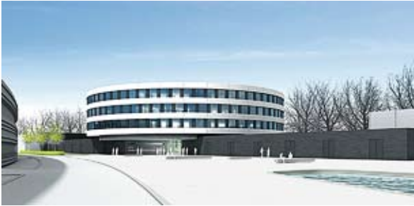
Noch im Bau befindet sich das Zentrum für „Free-Electron Laser Science“ CFEL
